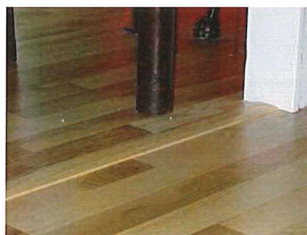
Bild 10. Tröskelplatta kan användas när tröskel tagits bort eller som avgränsning mellan olika golvmaterial. Här en cirka 6 millimeter hög tröskelplatta.
