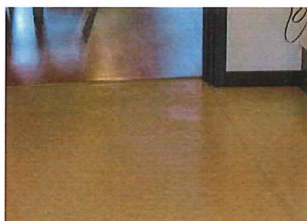
Bild 11. En mindre nivåskillnad (2 centimeter) kan jämnas ut med avfasning/uppspackling av golvet med flack lutning (max 1:50). En list ligger över skarven mellan golvmaterialen.
